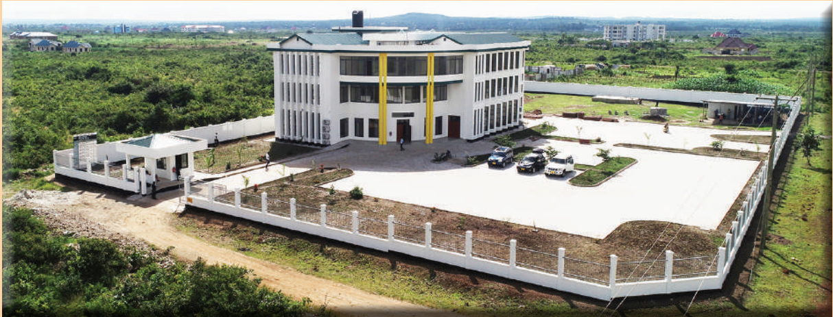
Muonekano wa Jengo la Ofisi ya Tanesco Mkoa wa Geita ambalo limebuniwa na kujengwa na TBA kama Mkandarasi na Mshauri Elekezi. Jengo hilo limeshakamilika na kukabidhiwa kwa matumizi tangu Januari 11, 2023.
