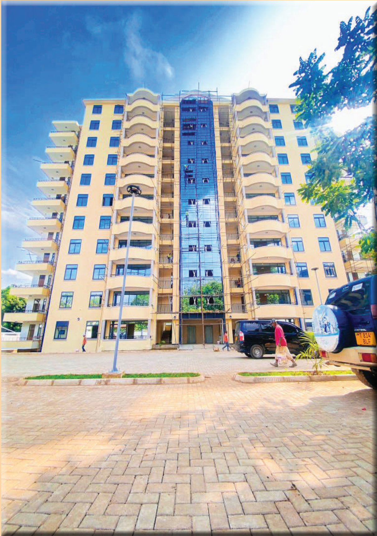
Mradi wa Ujenzi wa Jengo la ghorofa 11 kwa ajili ya makazi ya Watumishi wa Umma katika eneo la Simeon Jijini Arusha unaotekelezwa na TBA kama Mkandarasi na Mshauri Elekezi.
